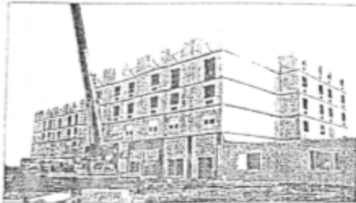
شکل ۱۹ استفاده از سیستم باربر (پانل قائم) در ساخت یک هتل در آمریکا
